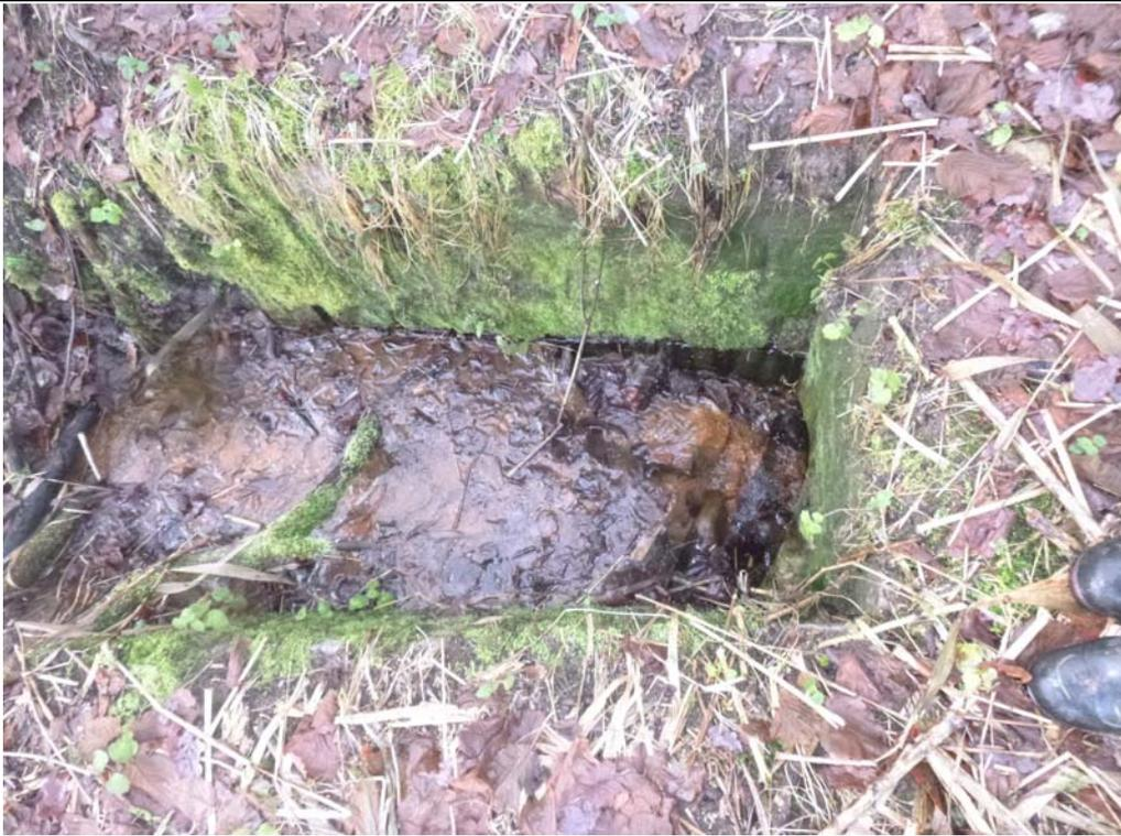
Foto 7: Krebsgraben; Einleitbauwerk in Regenwasserkanal
